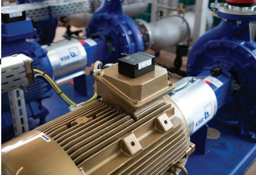
sfide dell'era digitale, compresa la soluzione per il monitoraggio KSB Guard, lanciata sul mercato qualche anno fa con grande successo. Oggi KSB ha aggiunto alla soluzione una nuova versione hardware per impieghi in atmosfere potenzialmente esplosive (Zona 1 ATEX con atmosfera gassosa).
